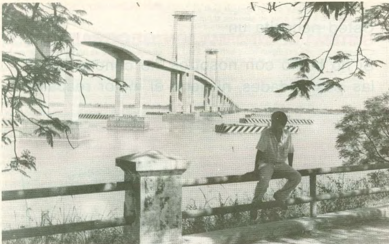
Puente General Manuel Belgrano que une las provincias de Chaco y Corrientes.
