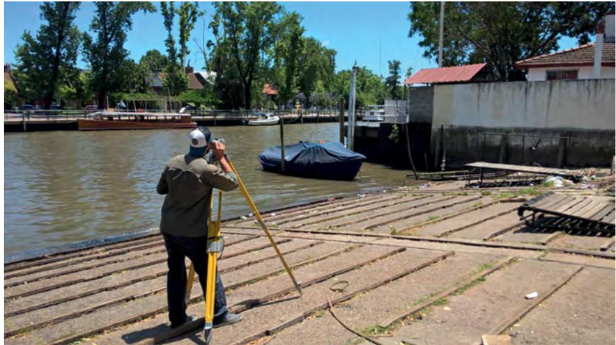
FIGURA 2. Relevamiento del cero de la Escala de Tigre. Personal del IGN.
