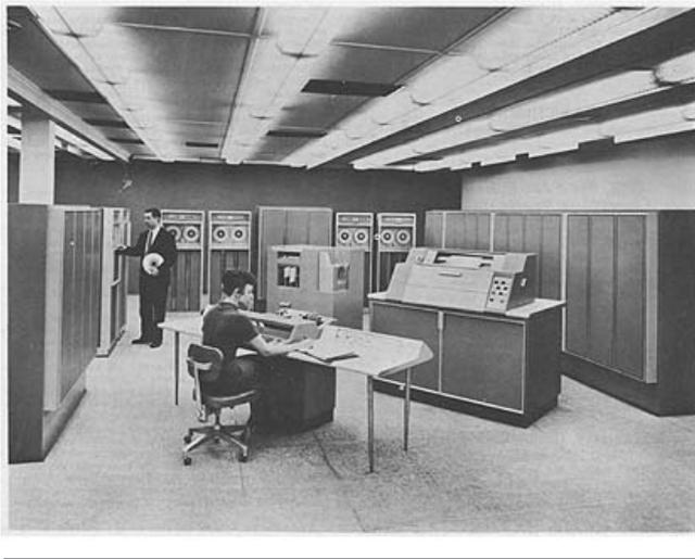
FIGURA 4: Unidad de procesamiento Honeywell 1800
