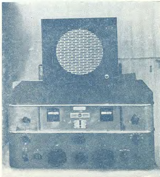
Receptor de radio con oscilador Telegráfico
