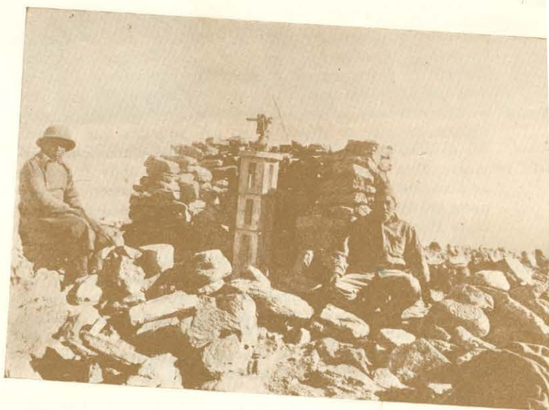
Reparo de piedras para evitar los fuertes vientos de la zona; construido en Cerro Granada a 5.700 m. de altura
