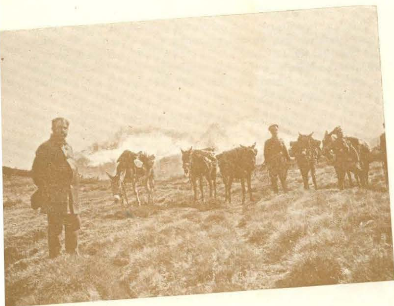
Dada la falta de caminos, hay que efectuar los trabajos a lomo de mula
