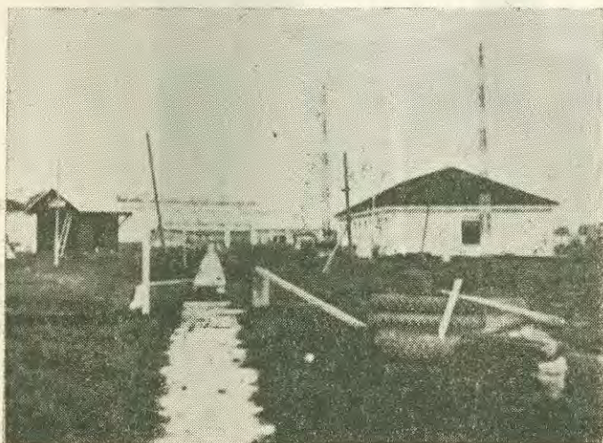
Conjunto de obras de las Instalaciones Ing. "José A. Alvarez Con- dareo". Inau- guradas en 1951, y que forman parte del Plan Quinquenal
