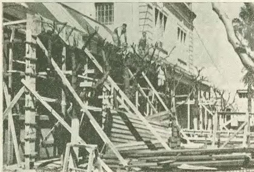
Un momento de la construcción de las galerías protectoras de la lluvia y el sol
